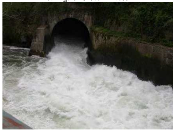
d. Diga di Creva - scarico
