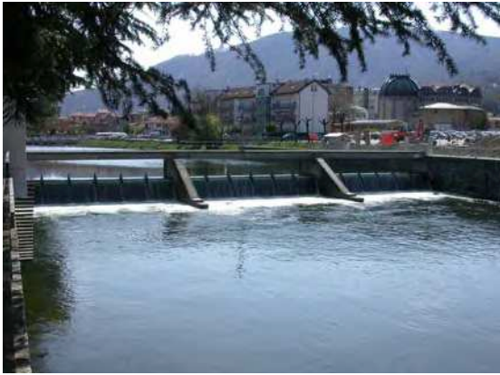
a. Sbarramento a paratie mobili a P.te Tresa
