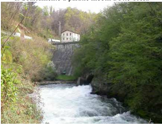
c. Diga di Creva - muraglione
